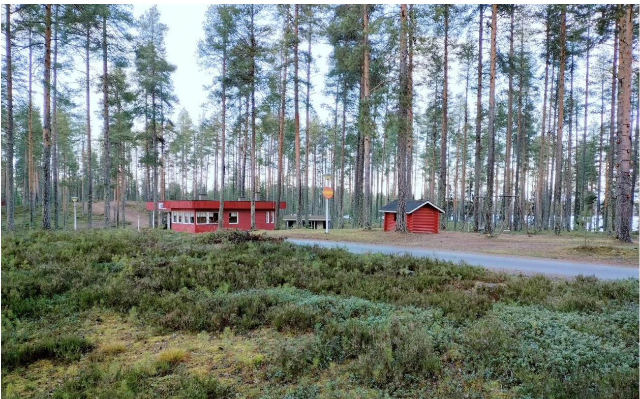
Kuva 1. Leirintäalueen nykyinen vastaanottorakennus.
