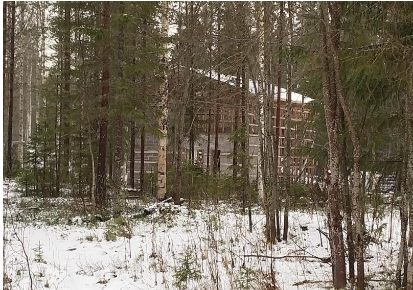
Rakenteilla oleva lämpökeskus
