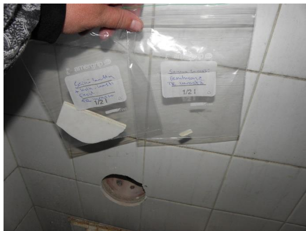
Kuva 6.4 Pesuhuoneen seinälaatan kiinnityslaasti, ei sisällä asbestia.
