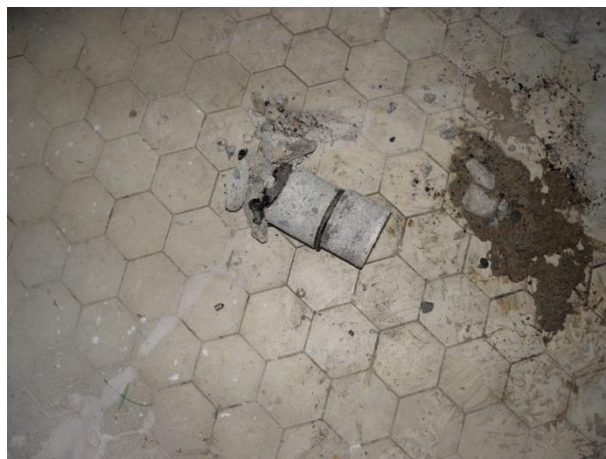
Kuva 6.2. Pesuhuoneen pikivalu, AP, ei sisällä asbestia
