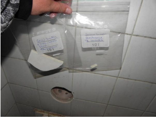
Kuva 6.5 Pesuhuoneen seinälaatan saumalaasti, ei si- sällä asbestia.
