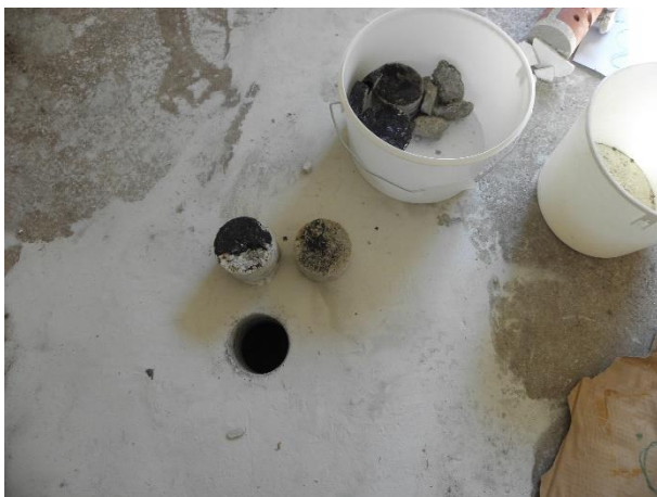
Kuva 6.3 Puuvaraston pikisively AP, ei sisällä asbestia.
