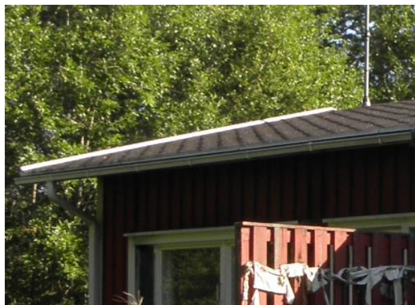
Kuva 6.2 Kattohuopa ei sisällä asbestia.
