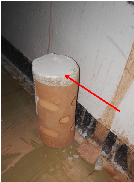
Kuva 6.3 1. kerros, sisäpuoliset tasoitteet ja rappaukset, kokoelmanäyte ei sisällä asbestia.
