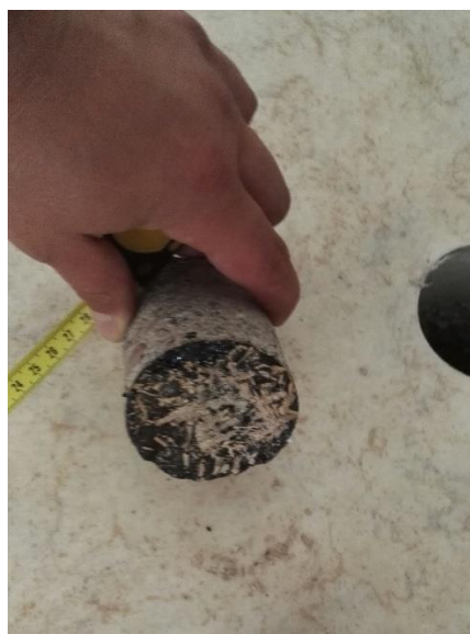
Kuva 6.2 1. kerros ja kellarikerros, alapohjan pikisively ei sisällä asbestia. Kuva 1. krs pikisivelystä.
