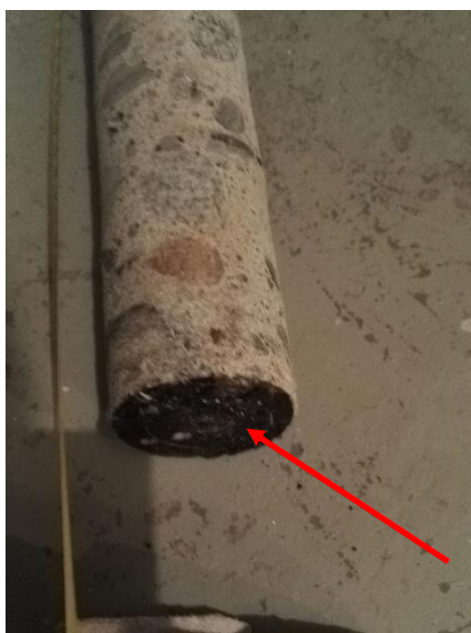
Kuva 6.1 Kellarikerros, perusmuurin pikisively ei sisällä asbestia.
