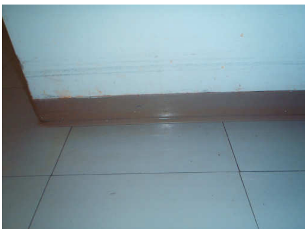
8d.Jalkalista D-osa, 1krs, ei sisällä asbestia
