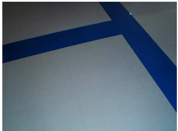
9.Lattialaatta + liima, sisältää asbestia
