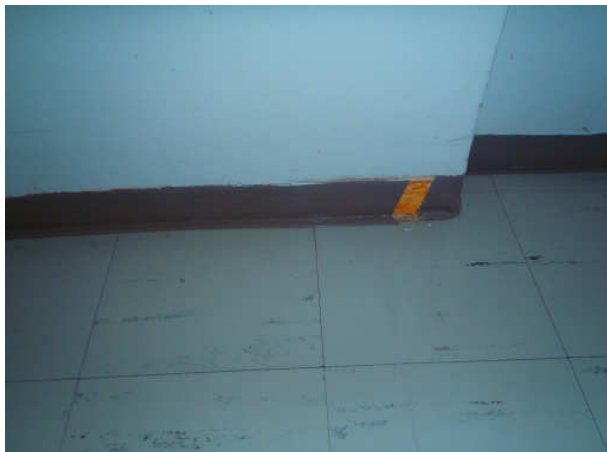
6E.Jalkalista, ei sisällä asbestia
