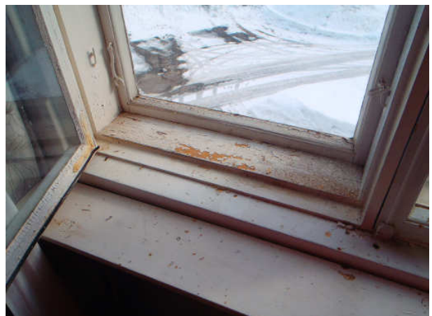
8E.Ikkuna ja ovimaali + karmit, sisältää arseenia, lyijyä, sinkkiä ja vanadiinia
