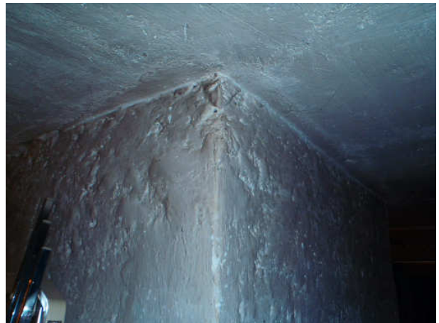
2E.Kiviseinä ja kattomaali ja tasoite, ei sisällä asbestia eikä raskasmetalleja.
